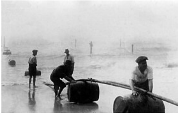
Salida de un cable Italia-EE.UU. (4704 millas náuticas de largo), en Rockaway Beach, Queens , Nueva York , enero de 1925.
